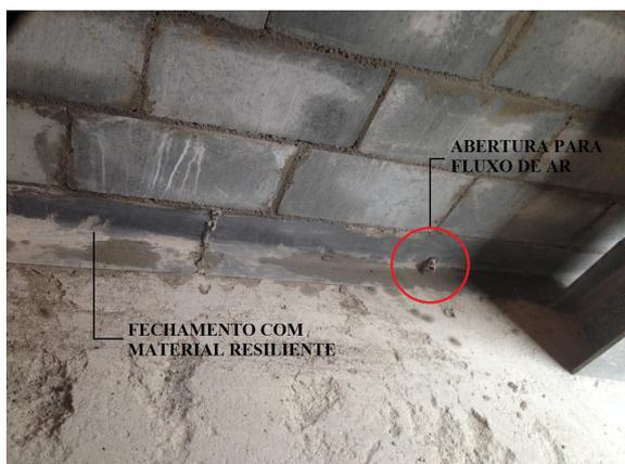
Figura 13: Cierre lateral en el perímetro del piso y apertura para flujo de aire.
